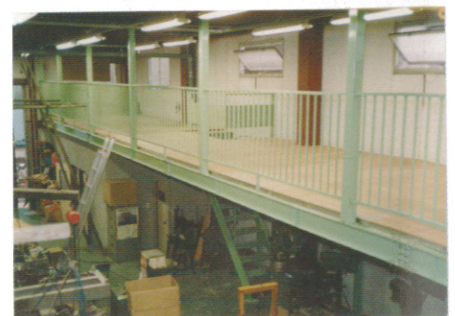
●合板（ボード）張り施工例
